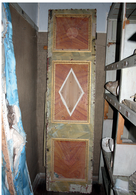
Илл. 1. Дверное полотно из фондов музея. Первоначальная отделка дверного полотна под красное дерево. Фото О. Е. Галаничевой, 2014–2021 гг.
