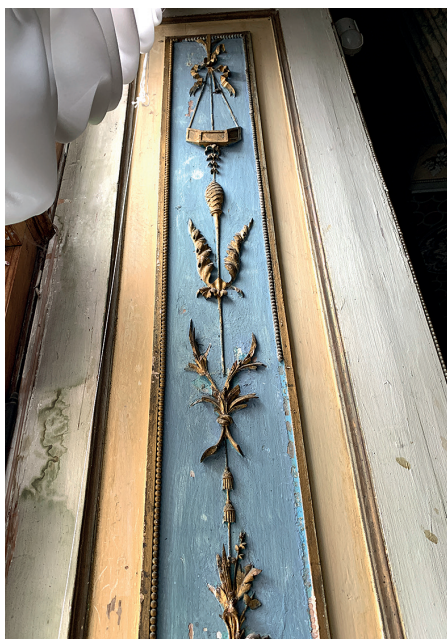
Илл. 2. Откос (коробка) оконного проема с первоначальной резьбой. Фото О. Е. Галаничевой, 2014–2021 гг.
