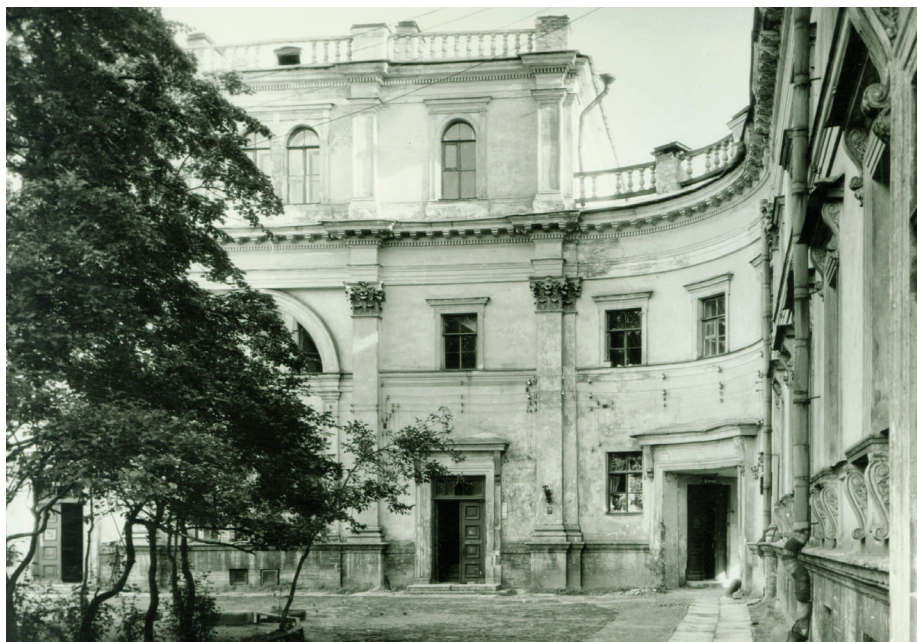
Илл. 4. Усадьба Г. Р. Державина (наб. р. Фонтанки, 118). Северный фасад главного корпуса. Фрагмент с закруглением западного флигеля, 1954 г. Ф. 488. Оп. 318. Д. 286
