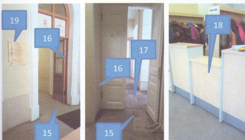
15. Участки пола на путях движения МГН за 0,6м перед дверными проемами не имеют тактильные предупреждающие указатели и и/или контрастно окрашенную поверхность в соответствии с ГОСТ Р 12.4.026, что **не соответствует п.5.2.3.**
